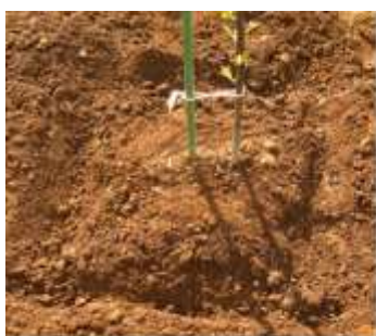
①溝を掘る
